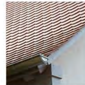
Geschlossene Ausführung von Ortgang und Traufe
