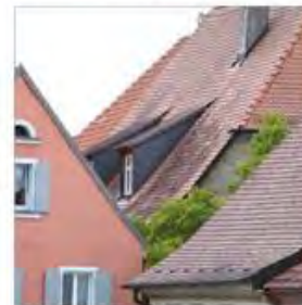
Ruhige Dachflächen ohne Dominanz von Auf- und Einbauten am Dach
