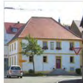
Walmdach an Sondergebäuden
