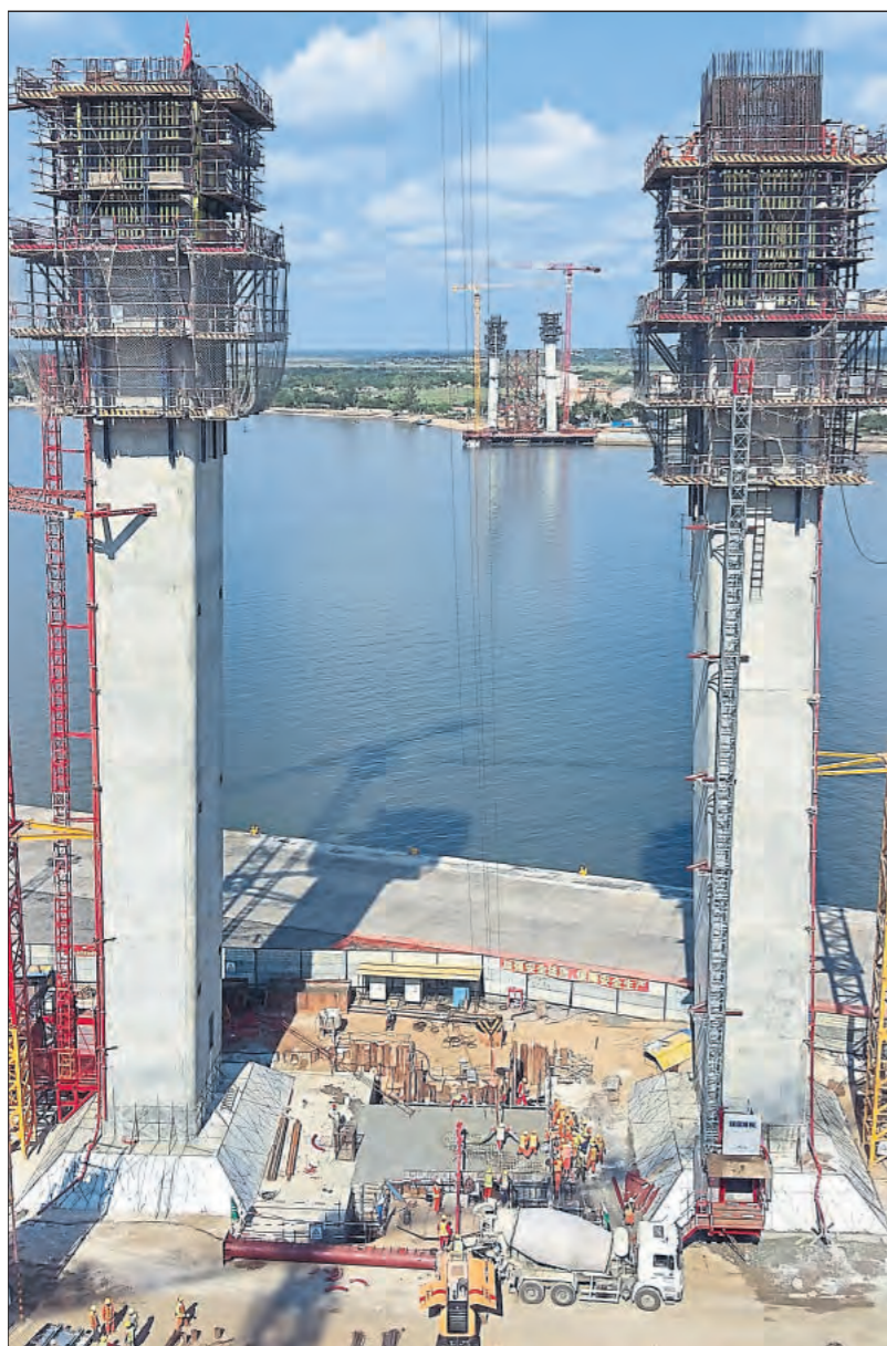
Die Dimensionen der Brücke sind enorm.
