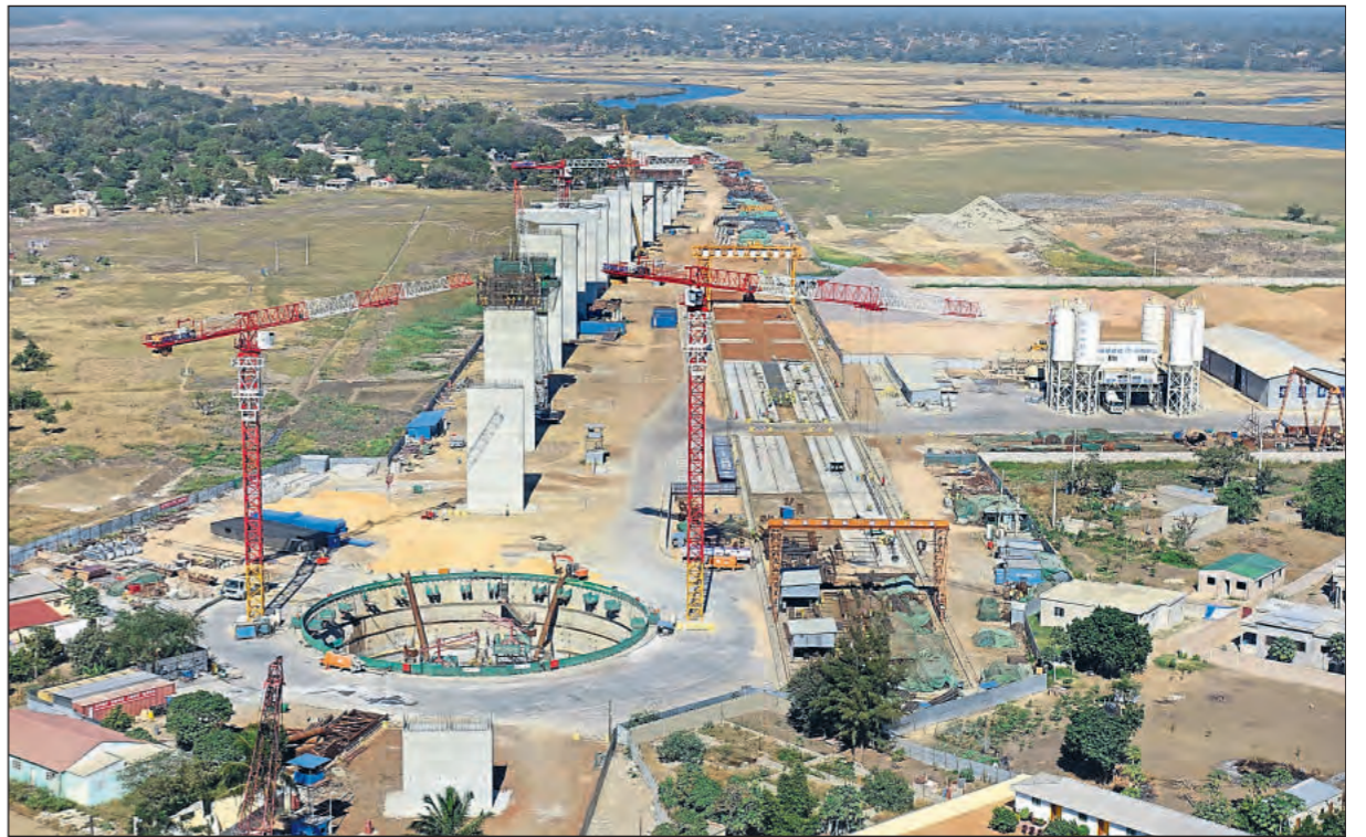
Ausbau des südlichen Ankerblocks, im Hintergrund die Stützen der Vorlandbrücke.
