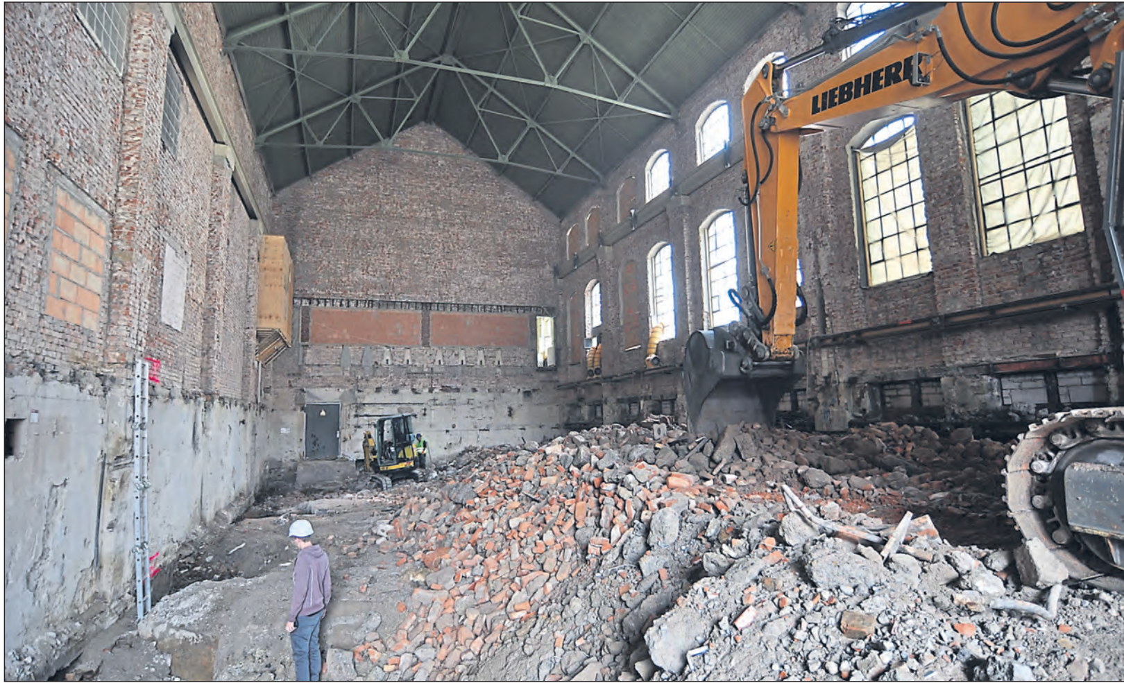
Abbrucharbeiten im Inneren des Bestandsgebäudes.
