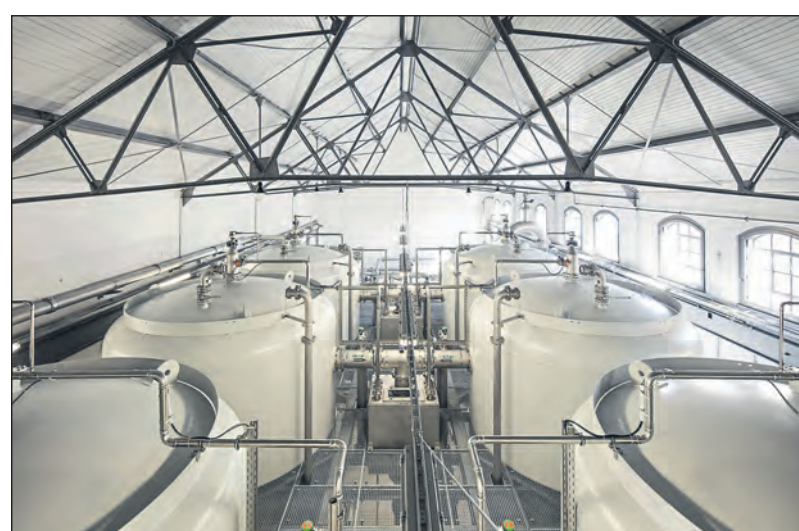
Die Aktivkohlefilterkessel nach Fertigstellung.
