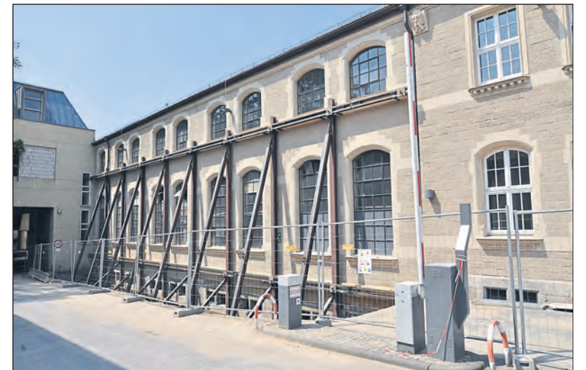
Bauwerkssicherung außen.
