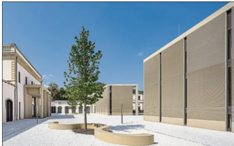
Im Innenhof wurden drei Neubauten errichtet.
